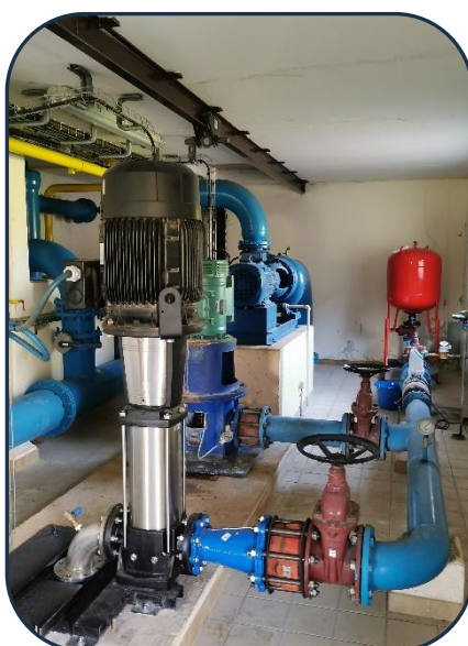
Station du Gué de Leugny
